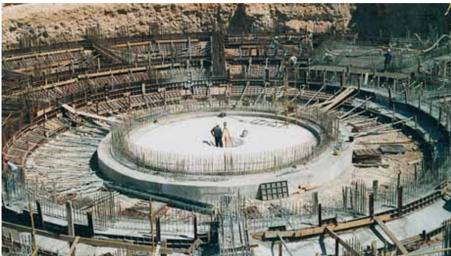
Verwaltungsgebäude Ersoc, DZ-Algerien; Fa. Travosider, DZ-Algerien
