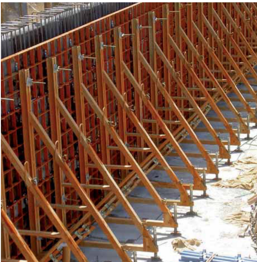
Einsatz des Eckgurtes bei 90°-Ecken
