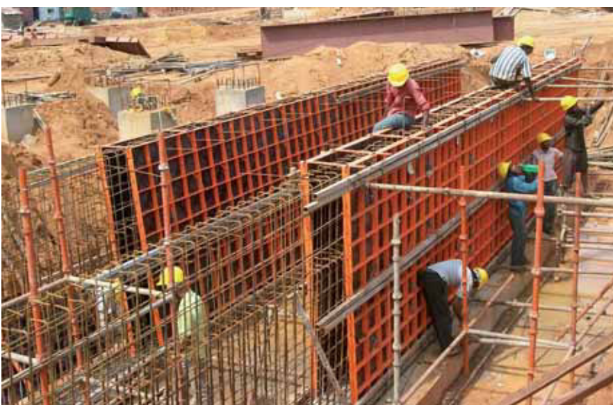
Kabelschacht für ein Heizkraftwerk, Korba, Chhatisgarh, Indien
