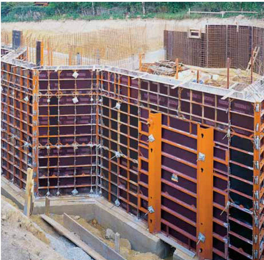
Wohnhaus, Jöbnitz; Fa. Vogtland Bau GmbH, Plauen
