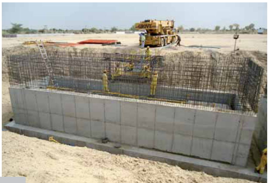
Bohrblock für Raffinerie, Barmer, Rajasthan, Indien
