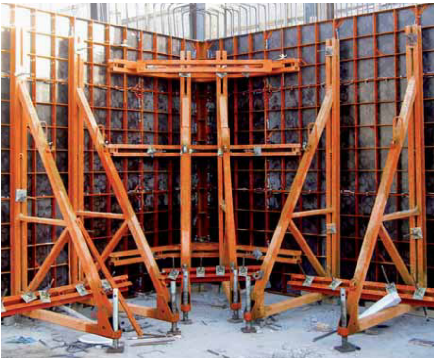
Einsatz des Eckgurtes bei 90°-Ecken
