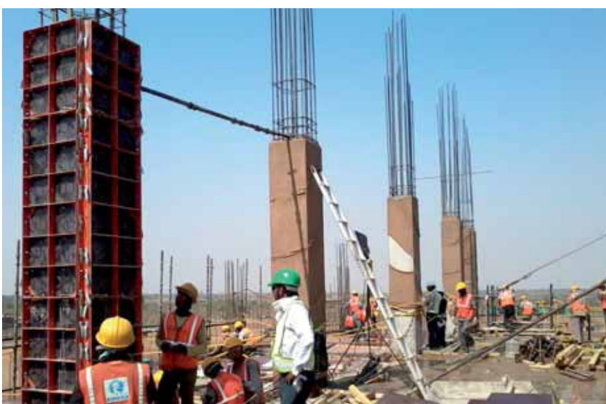
Nahrungsmittelfabrik, Baruch, Gujarat, Indien
