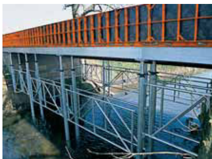
Brücke, Reichelsheim; Fa. Müller, Schotten
