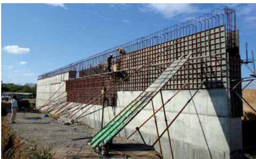
Durchlass für Ringstrasse, Warangal highway, Andhra Pradesh, Indien
