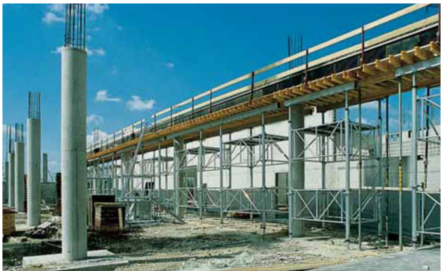
OBI-Baumarkt, Freiburg; Fa. Dyckerhoff & Widmann AG, Freiburg
