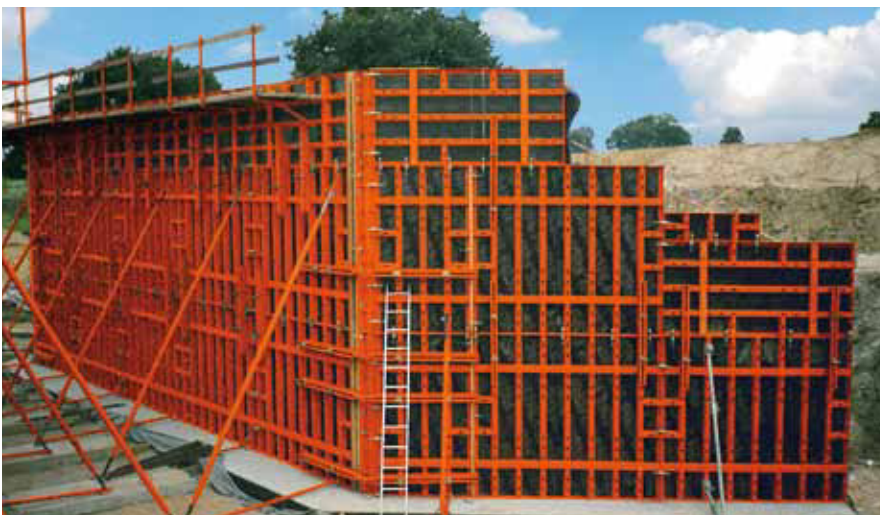
Ortsumgehung, Brühl, Westa-Bau GmbH, Ludwigslust
