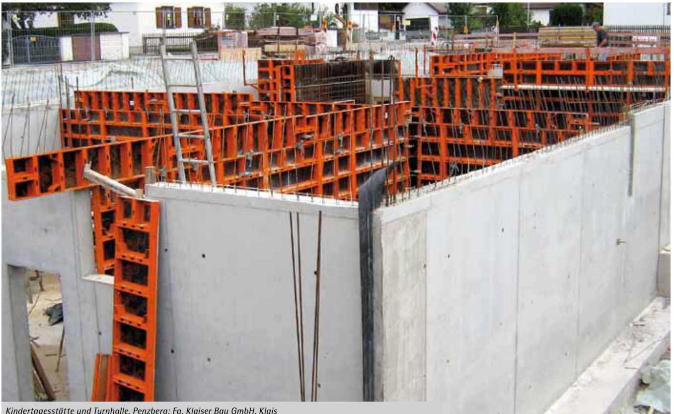
Kindertagesstätte und Turnhalle, Penzberg; Fa. Klaiser Bau GmbH, Klais
