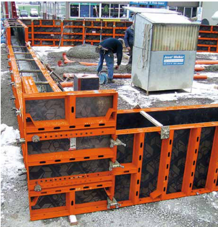
Wohnhaus, CH-Lachen; Fa. Walker Bau-Unternehmung AG, CH-Altendorf
