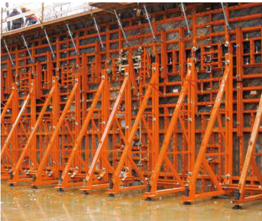
Kläranlage, Saarbrücken-Jägersfreude; Fa. Ottweiler Baugesellschaft, Ottweiler
