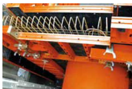
Hauptsammler, Saal; Fa. Neunkircher Baugesellschaft Neunkirchen
