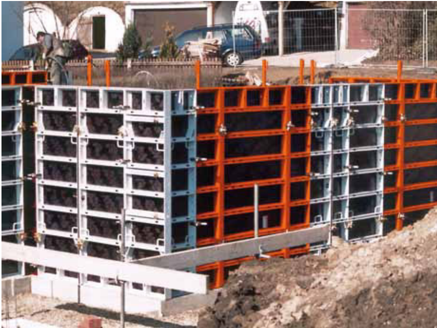
Wohnhauskeller, Ergolding; Fa. Lachermeier GmbH, Ergolding
