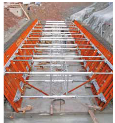
Regenrückhaltebecken, Göttingen; Fa. Tief-, Wasser- und Erdbau GmbH, Uder
