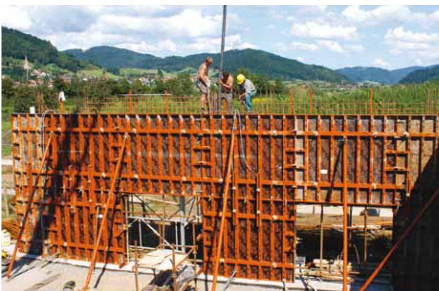
Produktionshalle, Haslach; Fa. Singler Bau, Hofstetten
