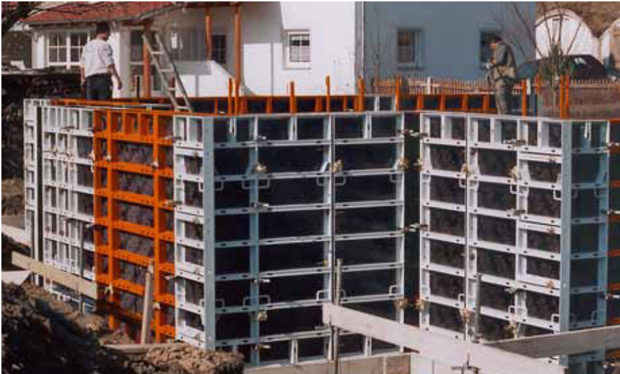
Wohnhauskeller, Ergolding; Fa. Lachermeier GmbH, Ergolding
