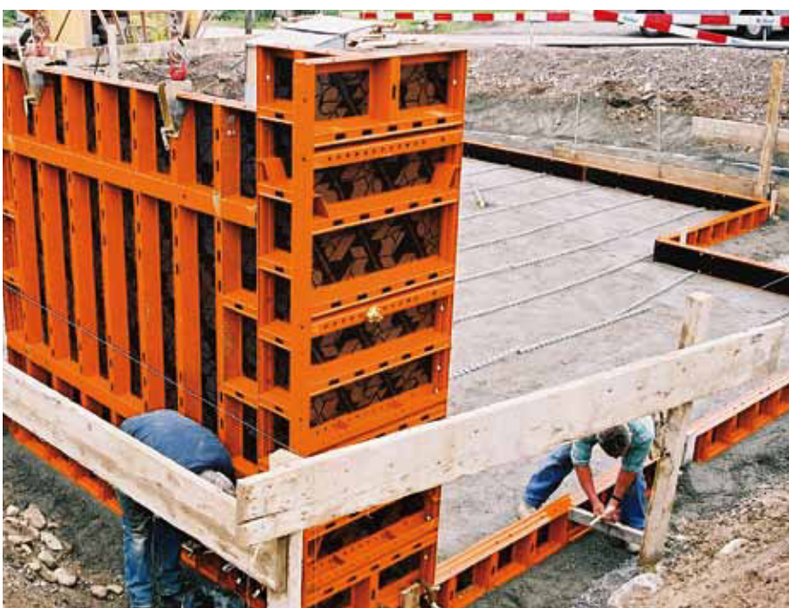
Trafostation, CH-Altendorf; Fa. Walker Bau-Unternehmung AG, CH-Altendorf
