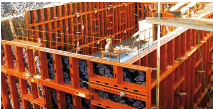
Wohnhaus, Aschheim; Fa. Feist Urban, Angelbrechting
