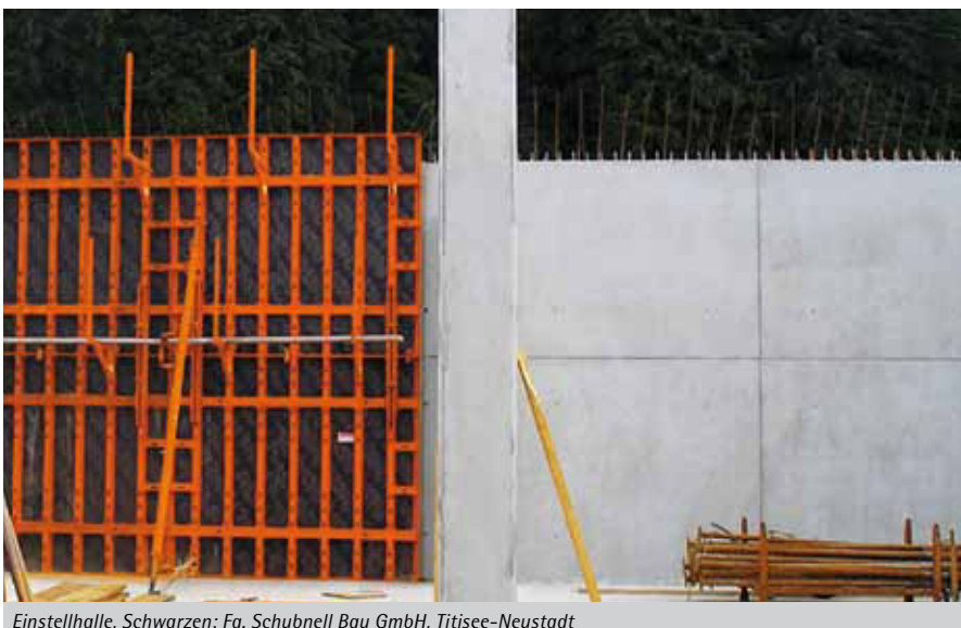
Einstellhalle, Schwarzen; Fa. Schubnell Bau GmbH, Titisee-Neustadt
