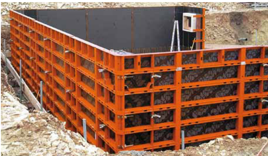
Wohnhaus, Engen; Fa. Steuer Bau GmbH, Blumberg Kommingen
