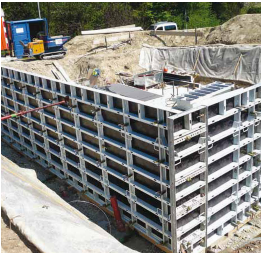
Wohnhaus, CH-Cortailod; Fa. Duckert Pierre SA; CH-Areuse
