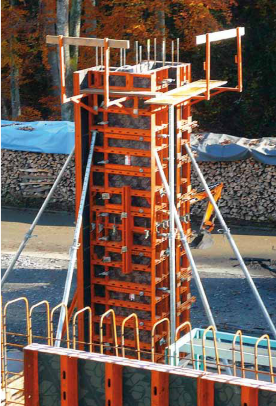
Einstellhalle, CH-Kerns; Fa. Baumeier Leitungsbau AG, CH-Luzern
