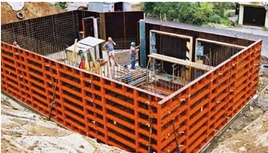
Wohnhaus, CH-Lachen; Fa. Walker Bau-Unternehmung AG, CH-Altendorf
