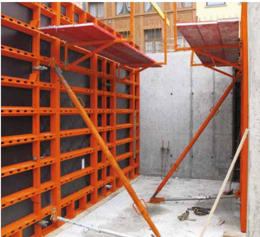
Wohn- und Geschäftshaus, B-Knokke-Heist; Fa. Furnibo bvba, B-Veurne
