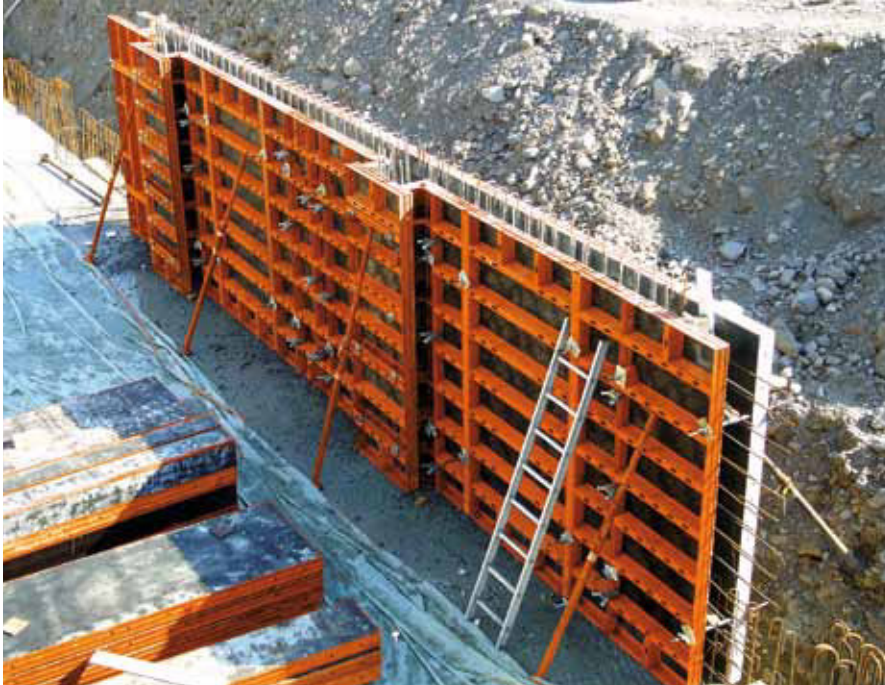
Verwaltungsgebäude, CH-Siebnen; Fa. Koller Akkord GmbH, CH-Pfäffikon
