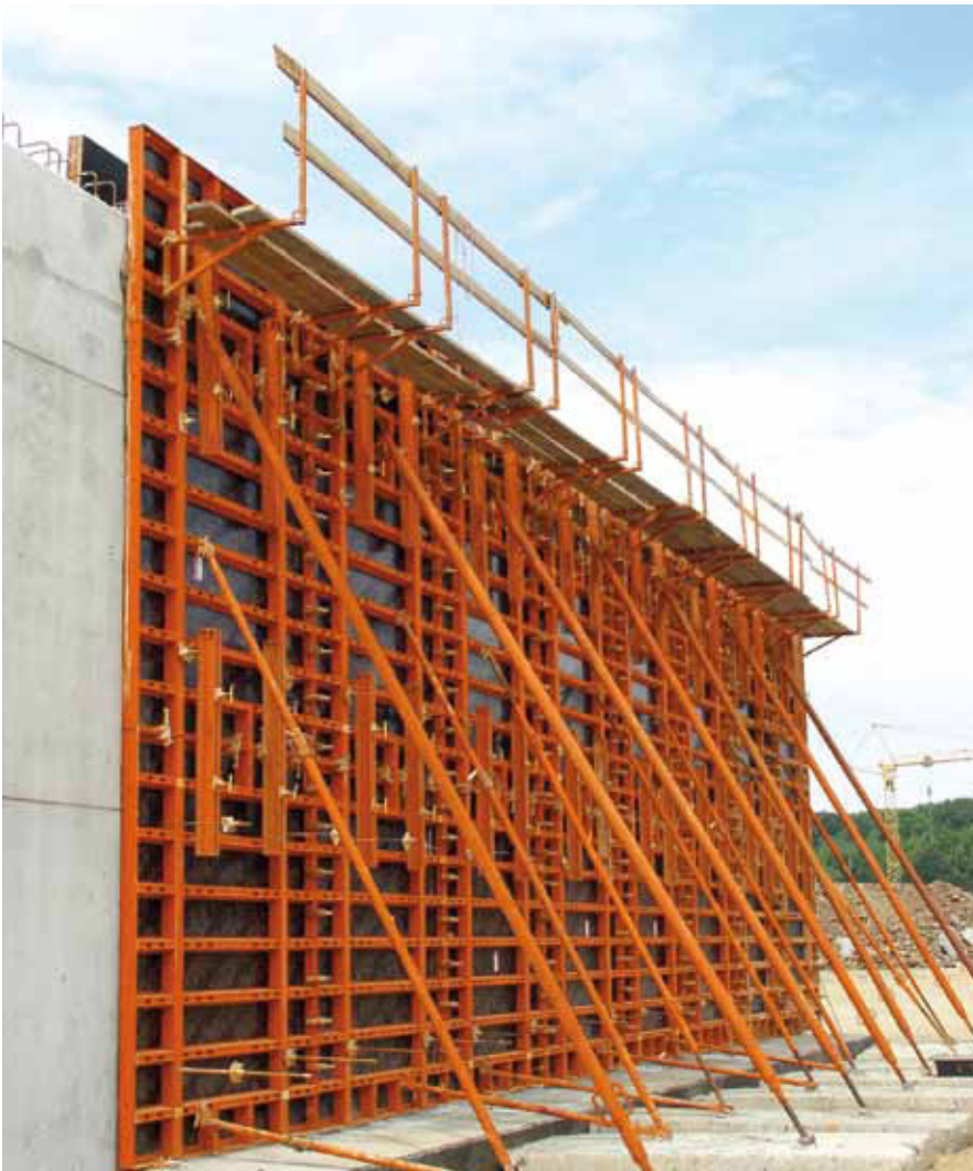
Fundamentwand für Autobahnbrücke, CZ-Pilsen; Fa. Berger Bohemia, a.g., CZ-Pilsen
