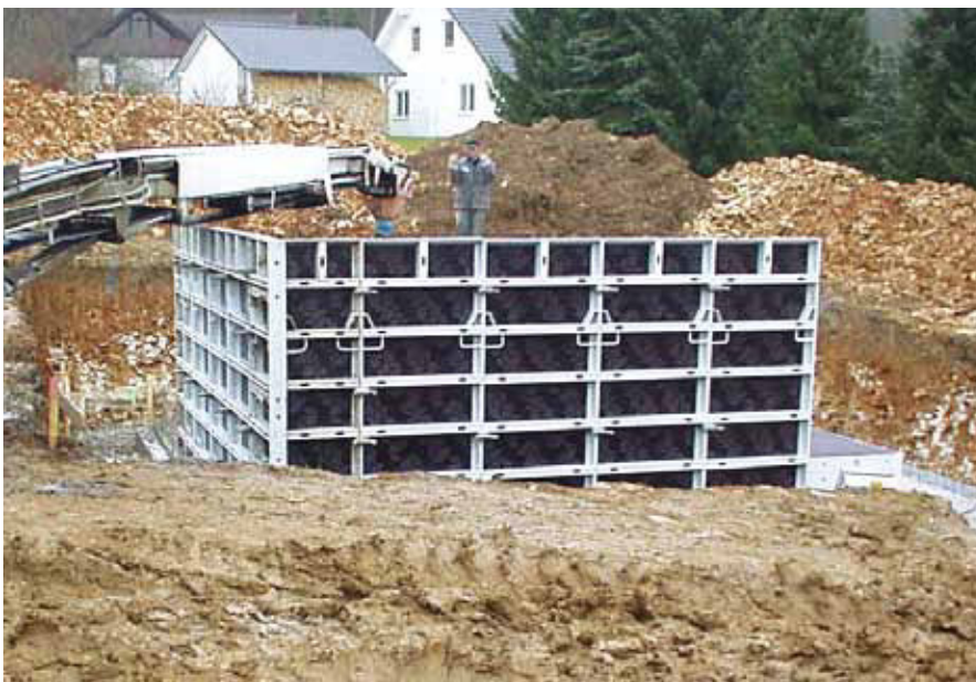
Wohnhaus, Unterschmeien; Fa. Rudolf Stauss, Unterschmeien
