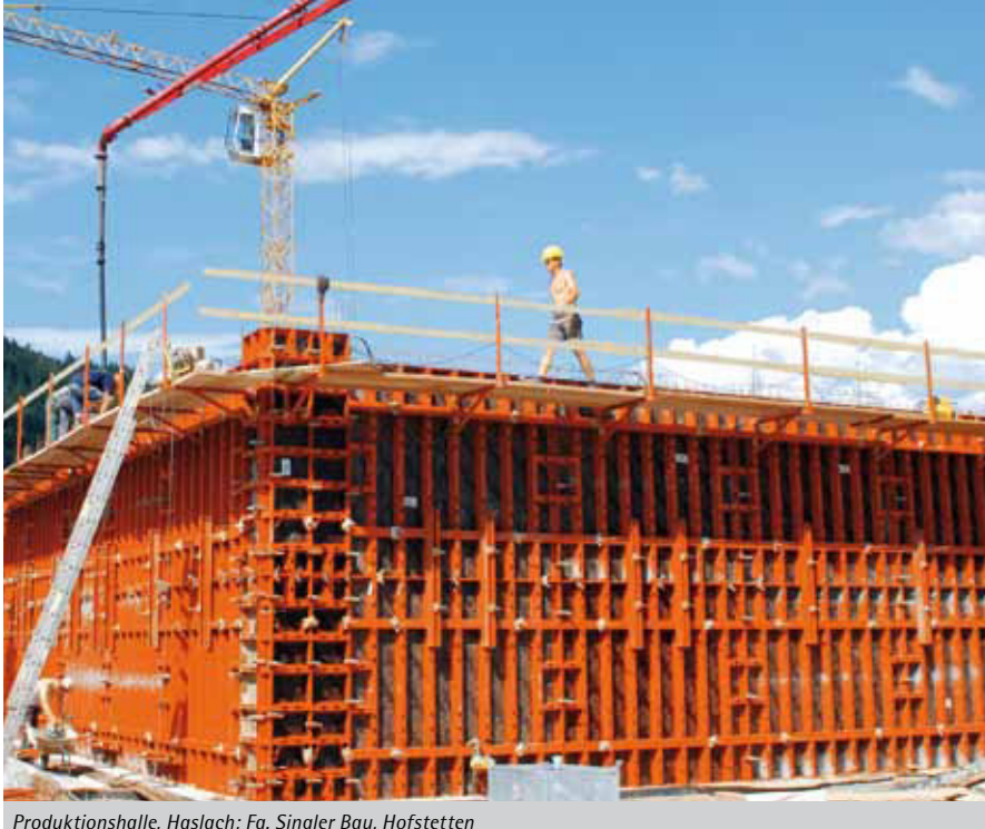
Produktionshalle, Haslach; Fa. Singler Bau, Hofstetten
