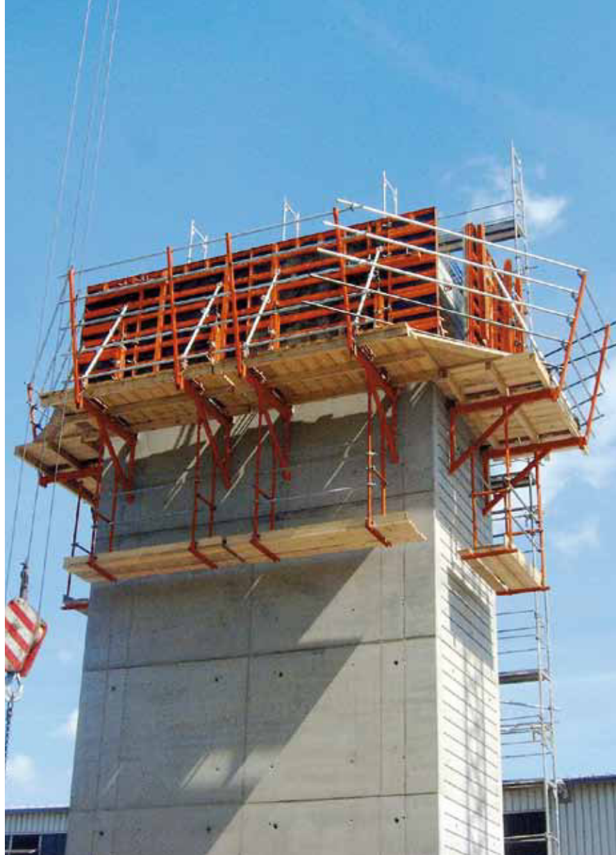
Treppenhaus Woll Maschinenbau GmbH, Saarbrücken; Fa. Linnebacher Bau GmbH, Neunkirchen
